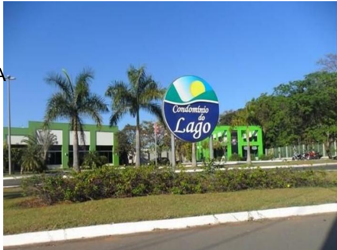
Fig. 3. Fachada Principal Condomínio do Lago
