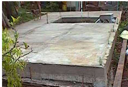
Fig. 3 – Contrapiso com raspa de pneu
