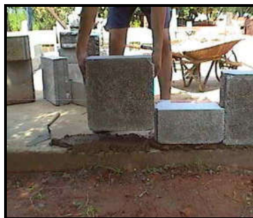
Fig. 4 – Modulação das paredes com blocos ISOPET
