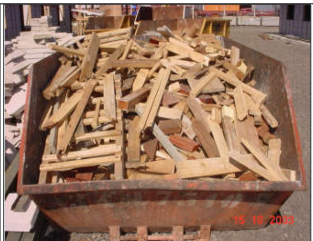
Foto 2 – Caçamba segregada com resíduo de madeira
