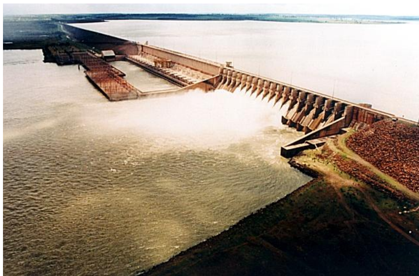
Figura 3 – Vista da UHE Jupia Fonte Memória da Eletricidade
