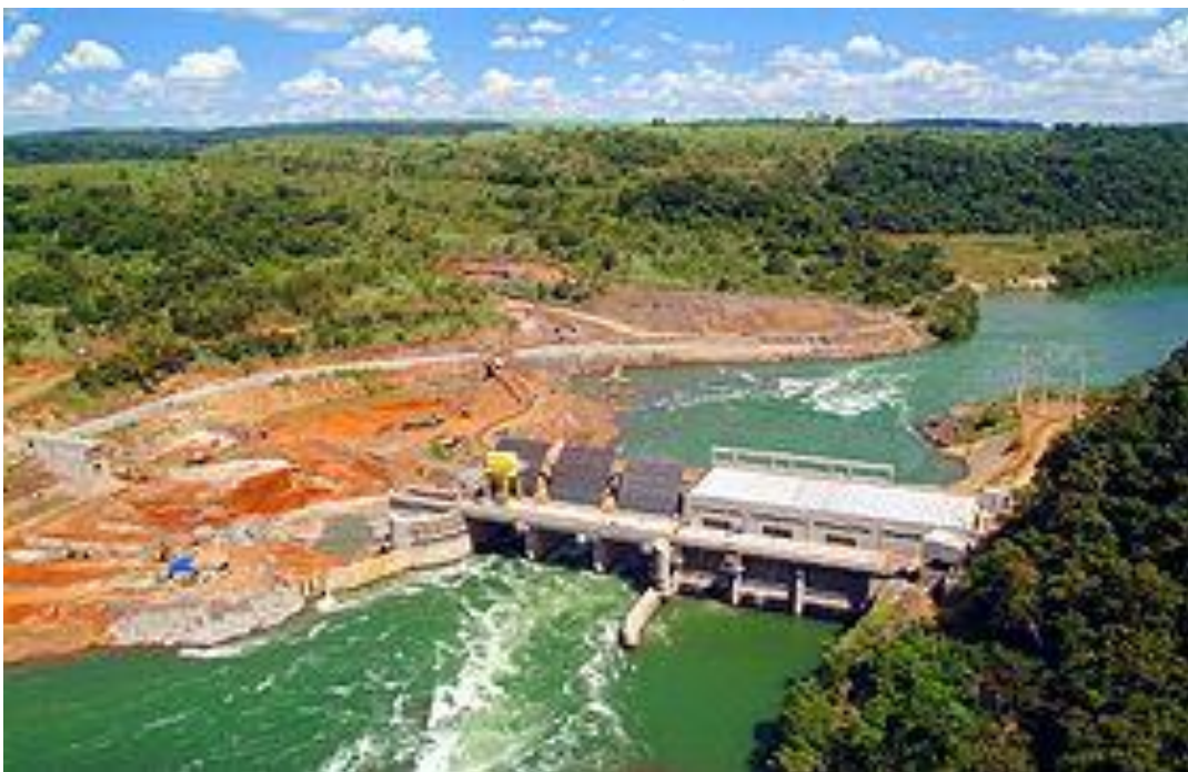
Figura 1 – Usina hidrelétrica de Ourinhos operando no rio Paranapanema. Potência Instalada: 44MW. Área alagada: cerca de 5.095 km 2 .
