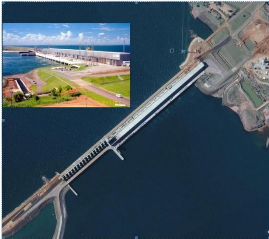
Figura 5 – Vistas da UHE Porto Primavera
