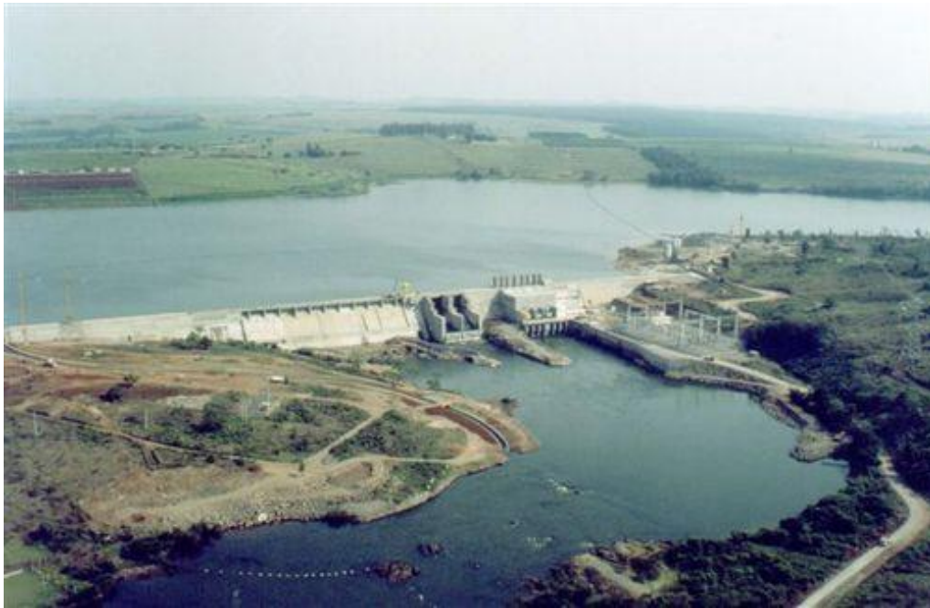
Figura 2 – Usina hidrelétrica Piraju, operando no rio Paranapanema. Potência Instalada: 80MW. Área inundada:13 km 2 .
