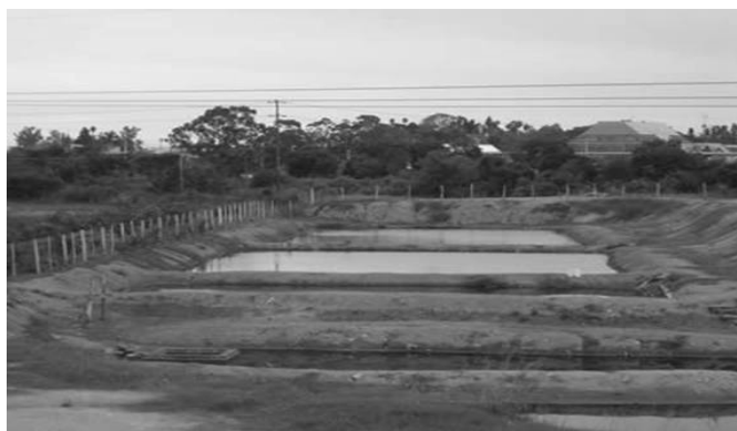
Fig. 6 – Imagem das lagoas de tratamento do chorume. Fonte: SANEP, 2008
