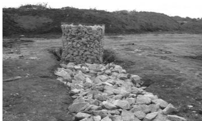
Fig. 7 - Imagem dos queimadores tipo flare do aterro de Pelotas.
