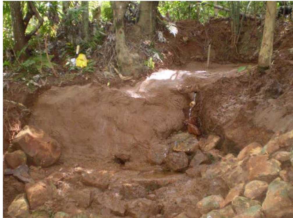
Recuperação de nascentes (Técnica Solo-Cimento)
