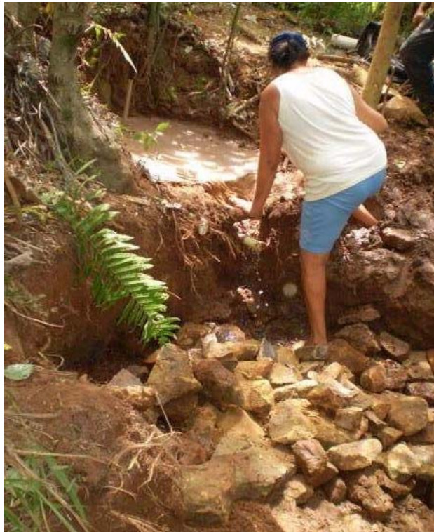
Recuperação de nascentes (Técnica Solo-Cimento)
