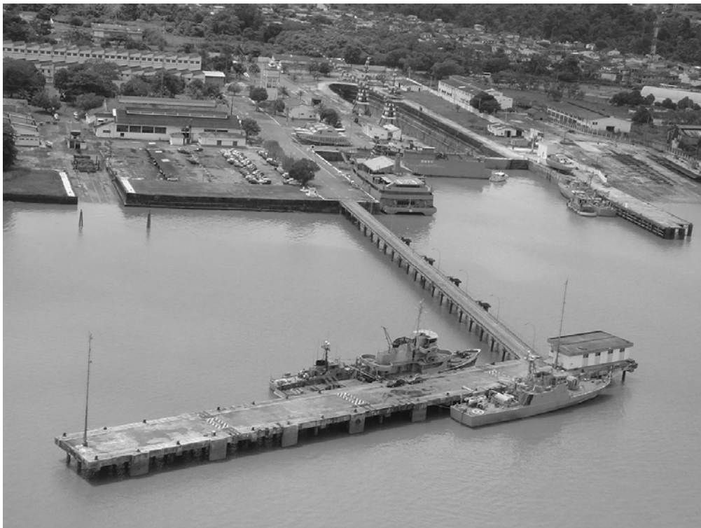
Fig. 1. Foto da Base Naval de Val-de-Cães, em Belém do Pará.
