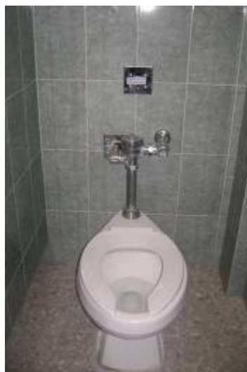
Figura 3. Sanitarios actuales en el edificio Turismo/ECEA
