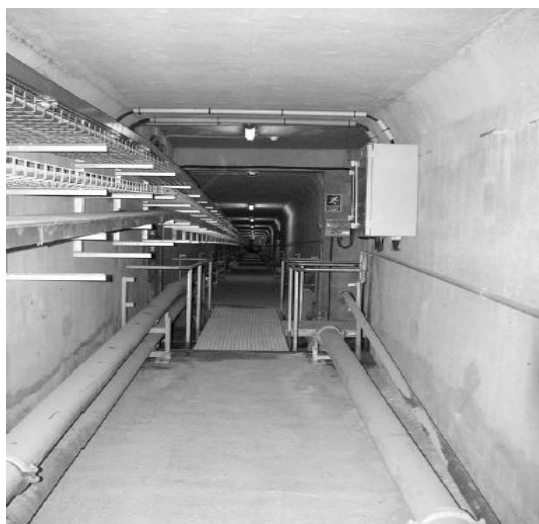
Fig. 2: Os túneis de multi-utilidade, onde em um mesmo espaço pode conter água, esgoto, energia elétrica, gás, telefone e aquecimento central. Fonte: HUNT& ROGERS, 2005
