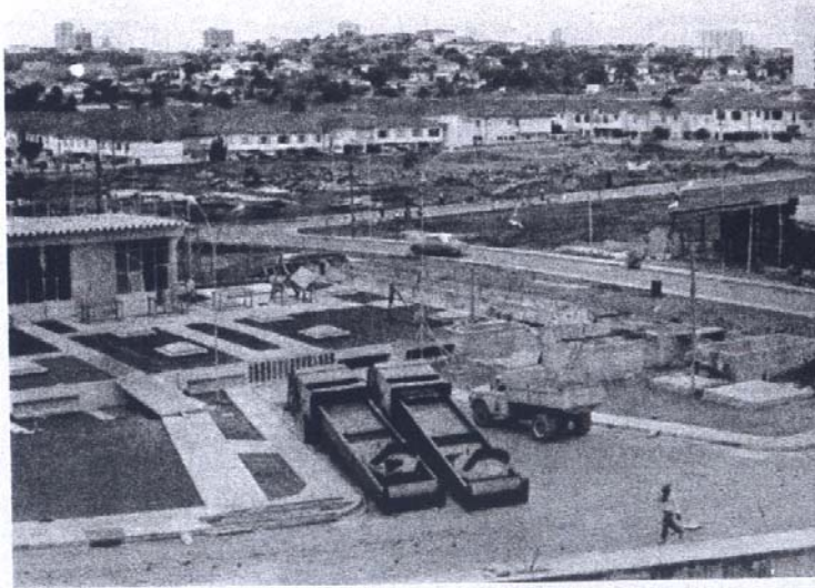
figura 1: Foto datada do início dos anos 70 da Estação Elevatória de Esgotos
