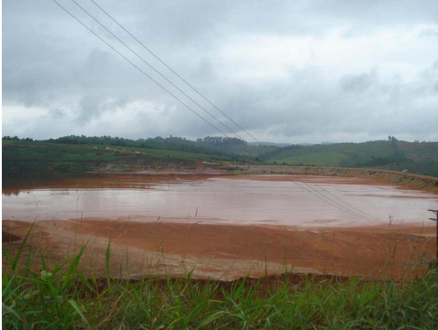
Lagoa de deposição da lama vermelha – Município de Alumínio (S.P.)
